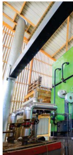
La serre de l'EARL Saint-Nicolas avec son ballon tampon d'eau chaude et sa citerne de CO 2 , photo FD
